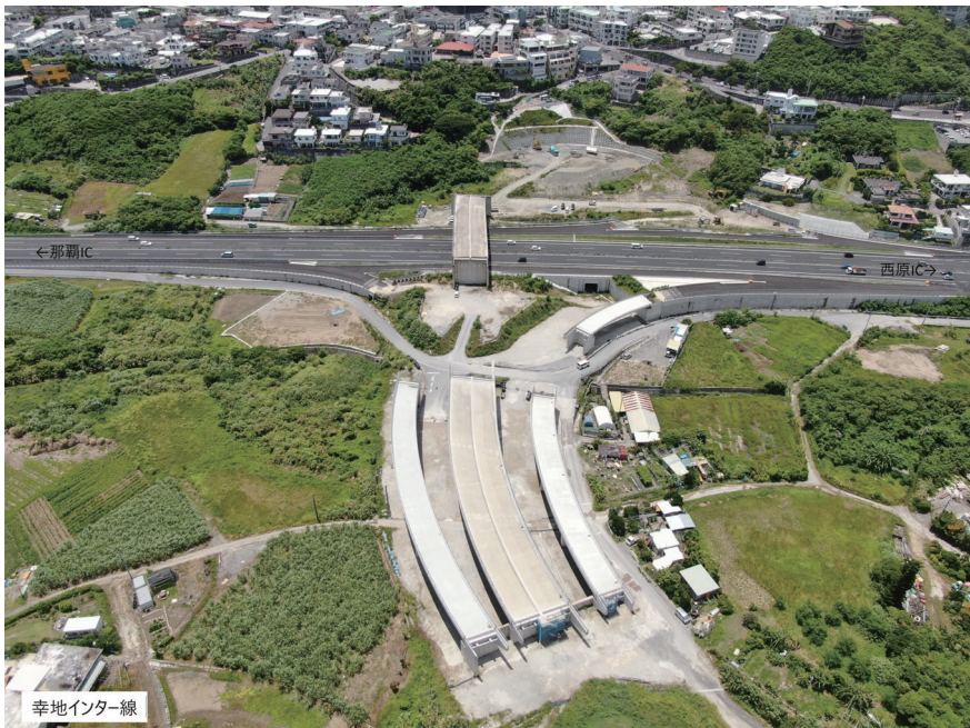
一般県道幸地インター線 整備状況（令和7年7月現在）
