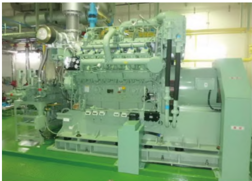
消化ガス発電機（那覇浄化センター）
