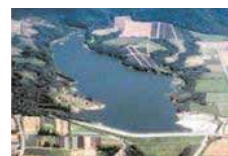
真栄里ダム (石垣島)
