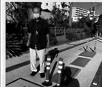
安岡団地前の県道の電線地中化ボックス設置予定の台座の段差につまずいて危ないと県と交渉。注意のポールが設置されました。
