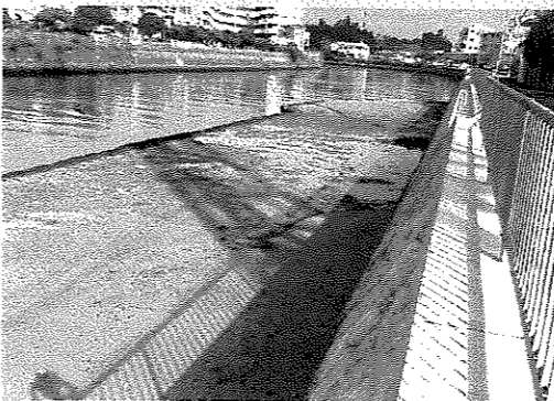
石川川護岸改修・浚渫工事完了 (台風等水害対策に期待)
