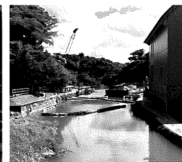
② 長田川取水ポンプ場
