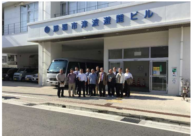
津波避難ビル⑥
