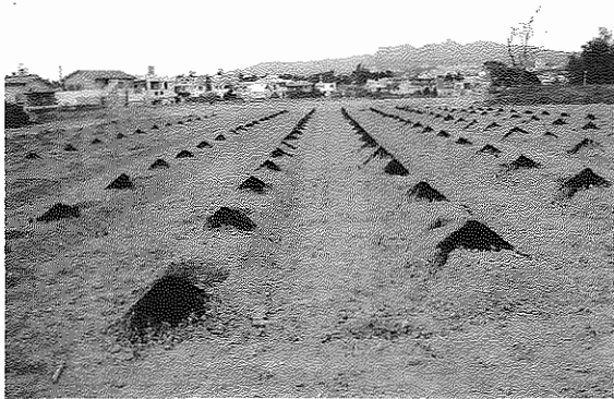
写真一． 植栽箇所の畝の状況
