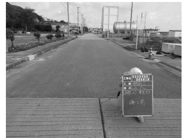
老朽化した舗装(臨港道路)
