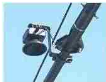
図 3-9 超音波式車両感知器
