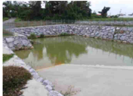
写真4 沈砂池
