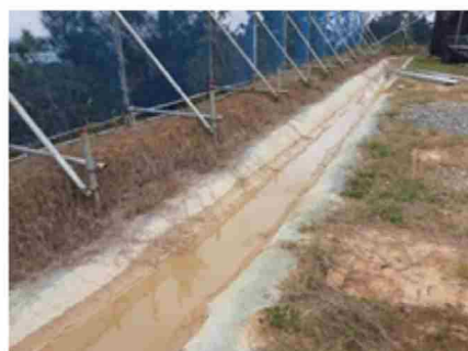
写真6 場内仮設排水路
