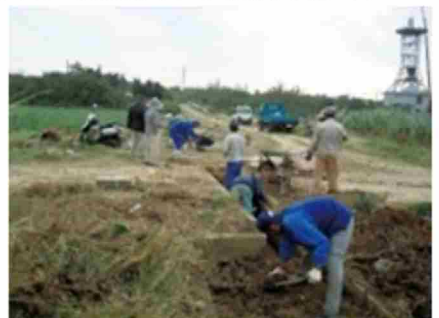
写真8 排水路や土砂溜樹の泥上げ
