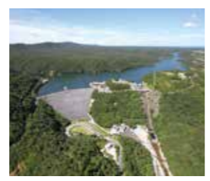
所在地:国頭郡東村川田 運営:沖縄総合事務局 北部ダム統合管理事務所
