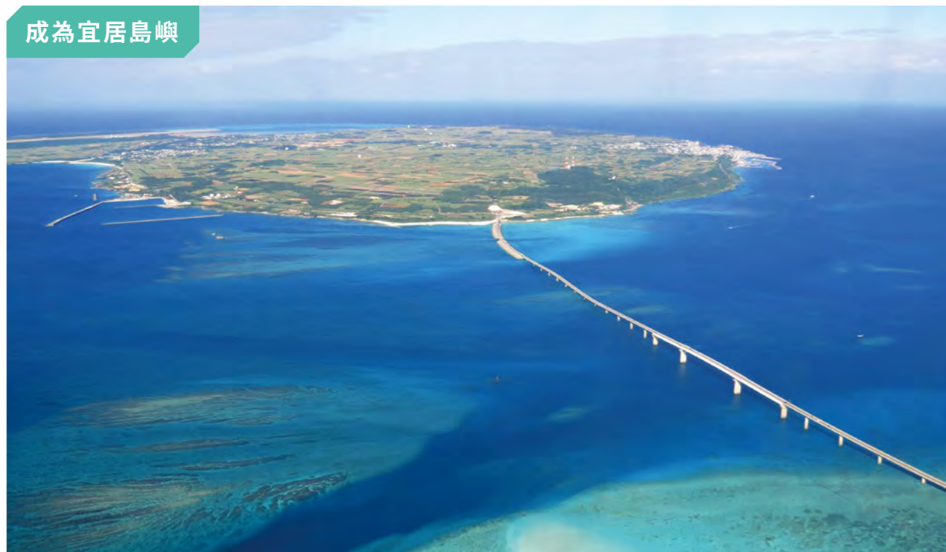
連結宮古島與伊良部島的伊良部大橋
