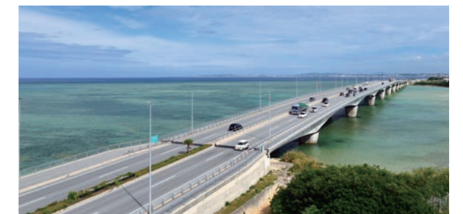
Autopista de la costa oeste nuevamente mejorada
