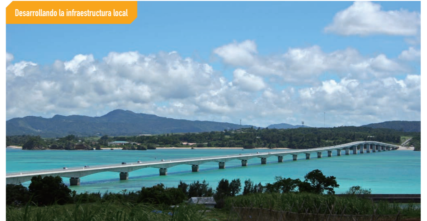
El puente Kouri conecta la Isla Yagaji y la Isla Kouri
