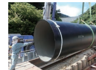
Llevando a cabo la renovación de las instalaciones de suministros de agua y antiterremoto
