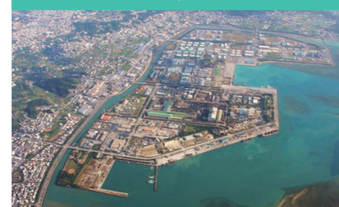
El puerto de Nakagusuku avanza en sus instalaciones para impulsar la industria (Nueva Zona Portuaria)
