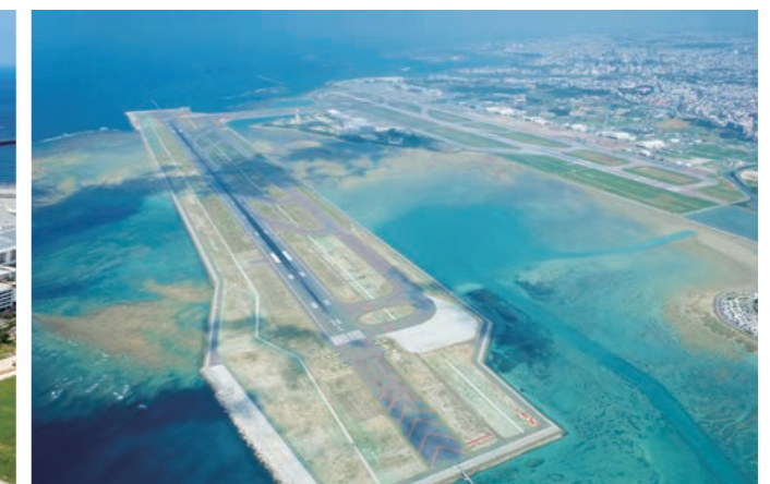
Segunda pista del Aeropuerto de Naha Foto cortesía de Oficina General de Okinawa, Ministerio de la Prefectura
