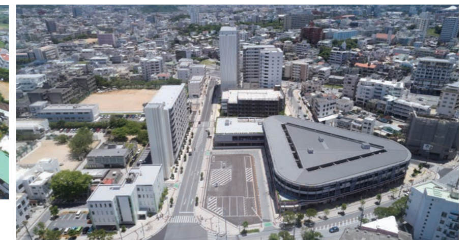
La zona de Naha Nouren, reforzada como área de prevención de desastres
