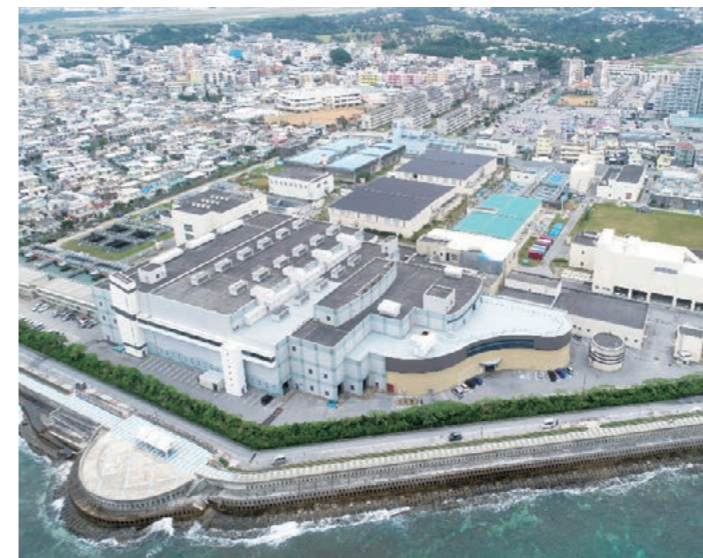
Centro de potabilizador de agua de mar de la oficina de tratamiento de aguas Chatan
