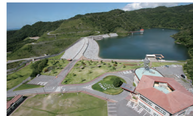
羽地ダム (沖縄総合事務局北部ダム統合管理事務所より)
