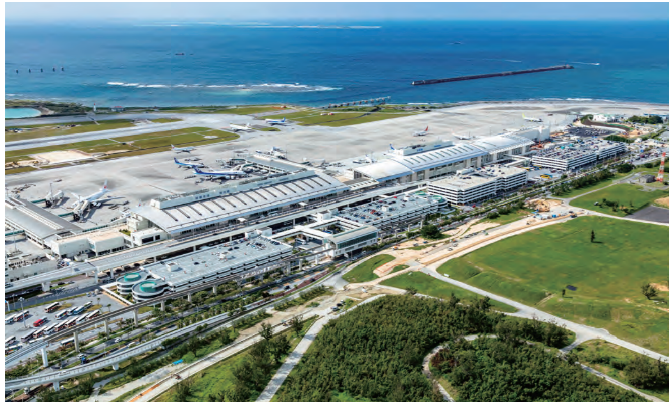
那覇空港ターミナル（那覇空港ビルディング株式会社提供）
