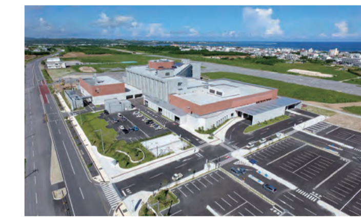
新県立八重山病院外観
