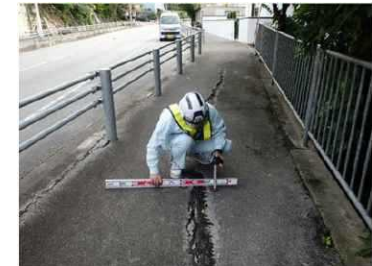
県道146号における舗装点検
