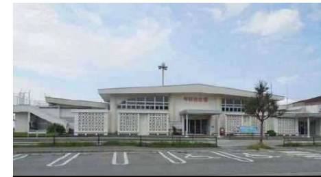
耐震化対象施設
