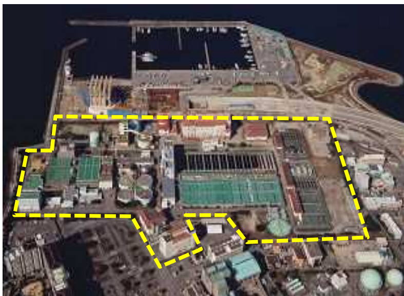
中部流域下水道・那覇処理区（那覇浄化センター）
