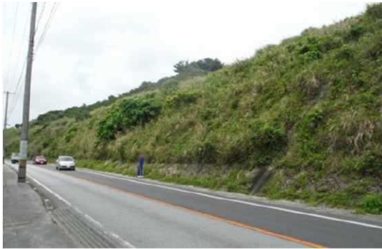
法面对策済みの道路を安全に通行する車両 (南風原知念線)
