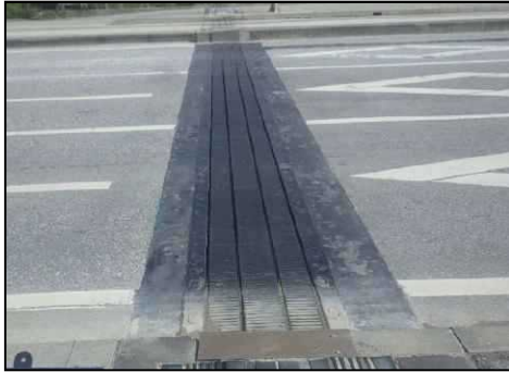
伸縮装置取替【国道449号】
