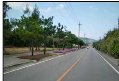
植樹柵: 古宇利屋我地線(古宇利大橋)
