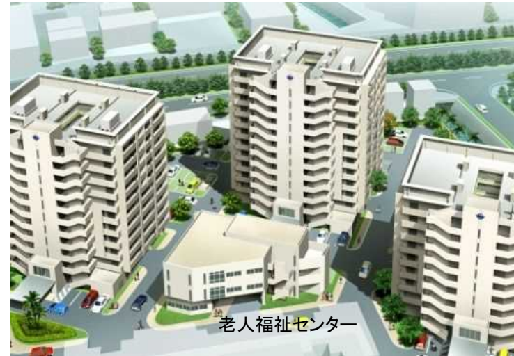
宜野湾市伊佐・伊利原市営住宅(老人福祉センター併設)
