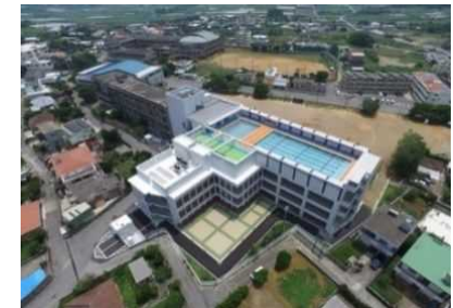
<糸満市兼城小学校> (水泳プール整備)
