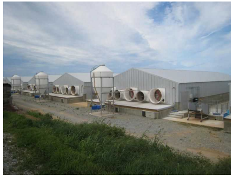
肥育豚舎及び付帯施設
