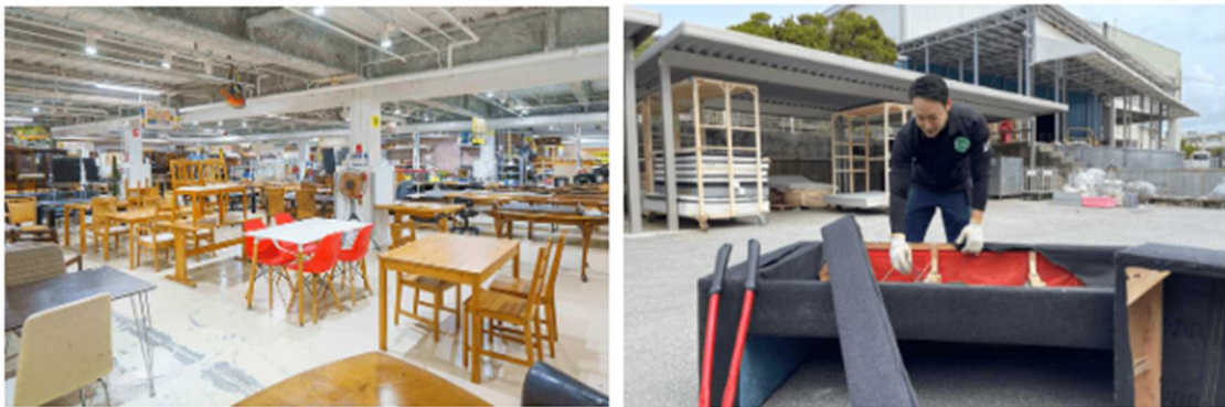
図 14 左：ReOK の店の様子／右：傷みや汚れで販売できない家具を解体する様子
