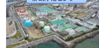
那覇浄化センター
