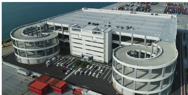
令和元年5月に開業した那覇港総合物流センター
