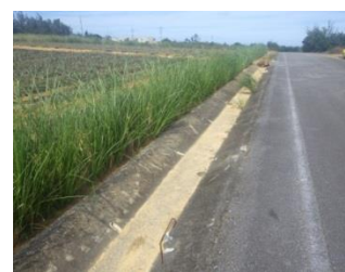
グリーンベルト(ベチバー) 赤土等流出防止対策
