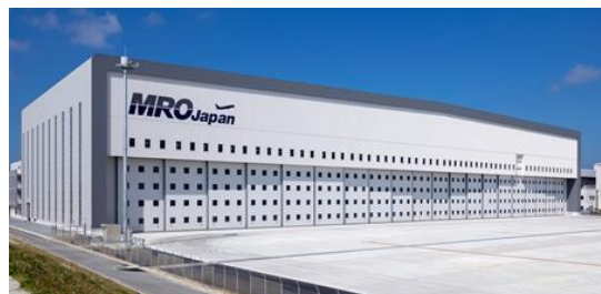
航空機整備施設 (H30年11月供用開始)
