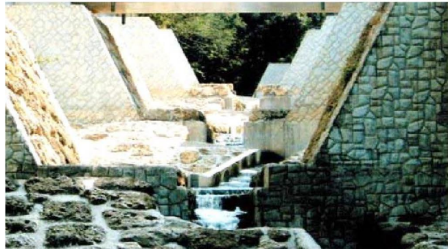
宜野湾市宇地泊川(流路工整備後)
