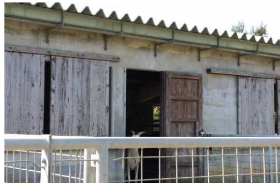
(壁や梁はコンクリート製、折板屋根)
