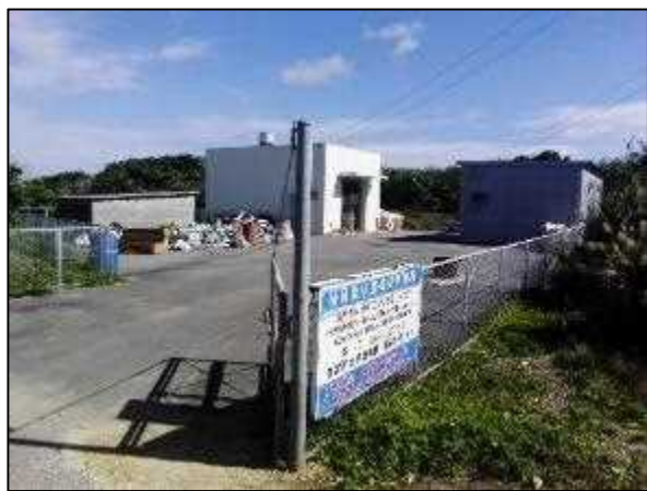
写真⑮ 焼却施設
