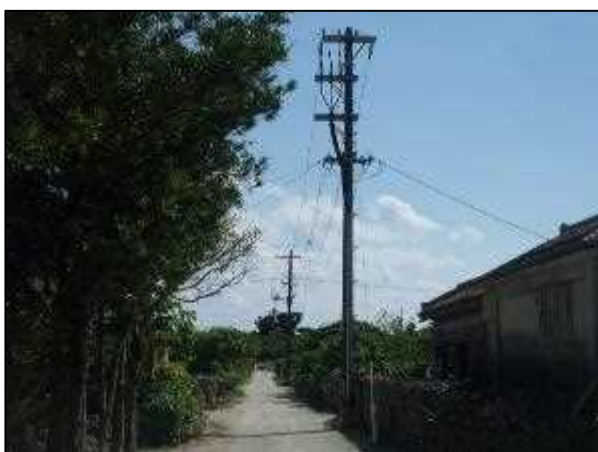
写真㊼ 高圧線埋設部 5
