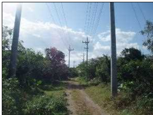
写真㉗ 高圧線ルート 11
