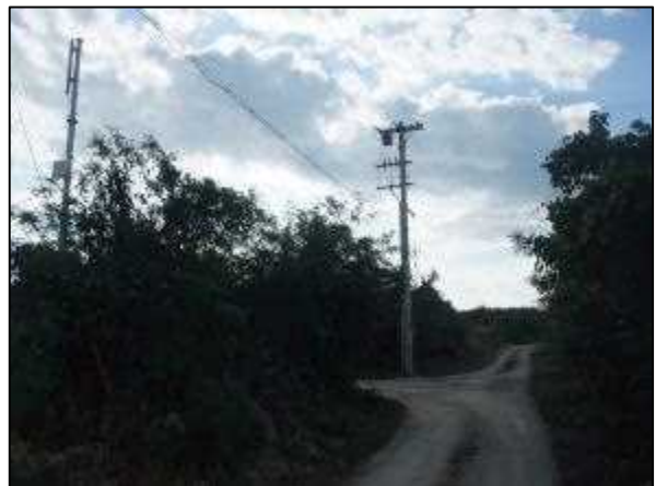
写真⑱ 高圧線埋設部
