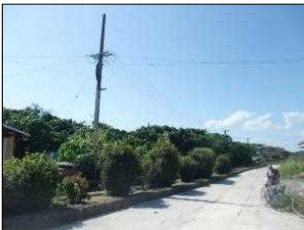
写真㊺ 高圧線埋設部 3
