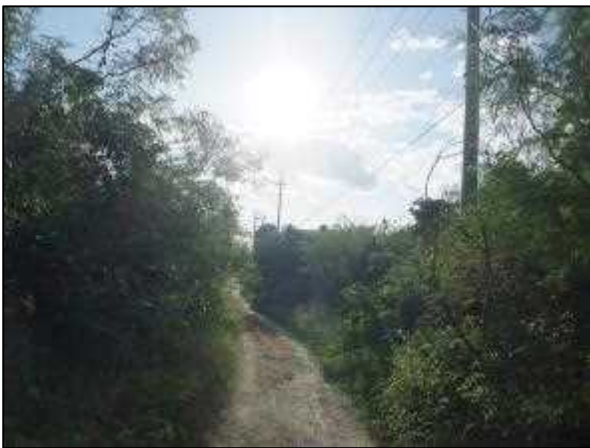
写真⑮ 高圧線ルート 7
