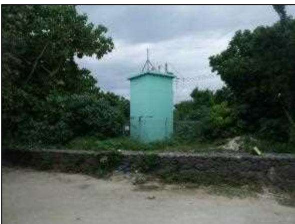
写真⑪ 海底ケーブル立ち上がり
