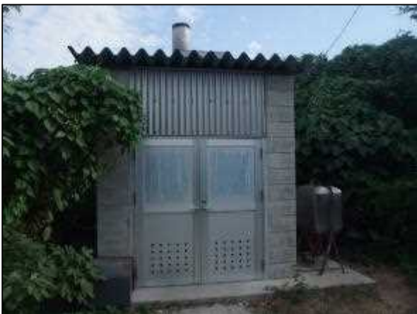
写真⑰ ボイラー施設
