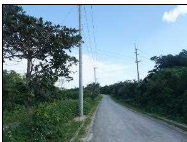
写真⑨ 高圧線ルート 9
