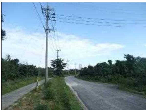
写真㉔ 高圧線分岐 6(海底ケーブル立ち上がり)
