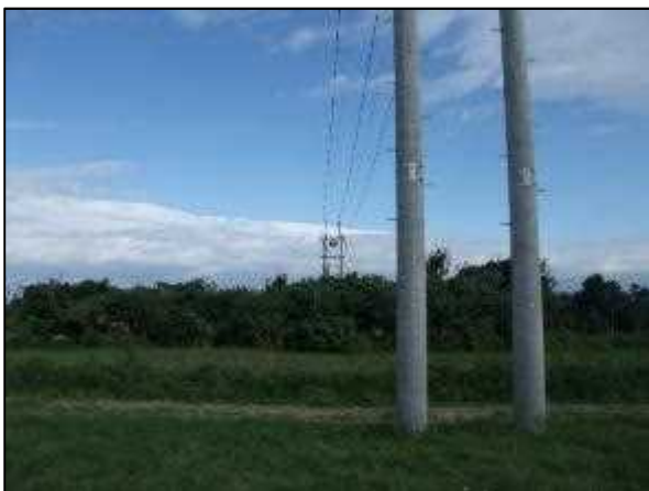
写真⑤ 海底ケーブル立ち上がり
