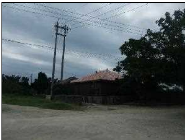
写真㊸ 沖縄電力竹富配電塔
