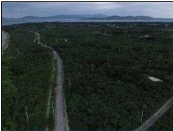
写真⑬ 高圧線ルート 5
