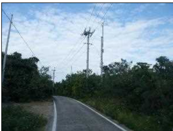
写真⑥ 高圧線ルート 7
