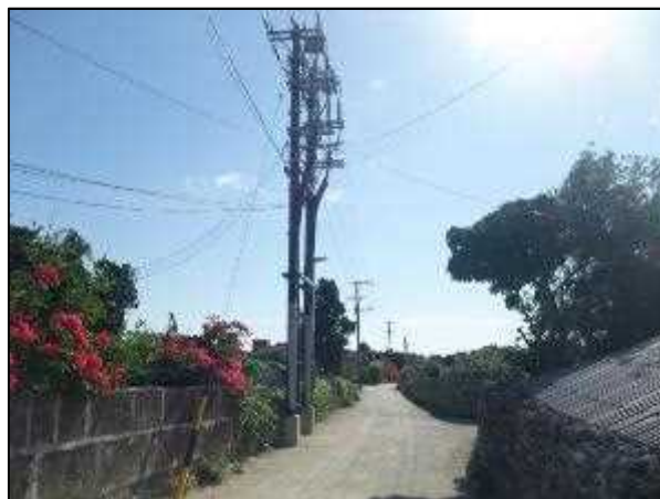
写真㊻ 高圧線埋設部 2
