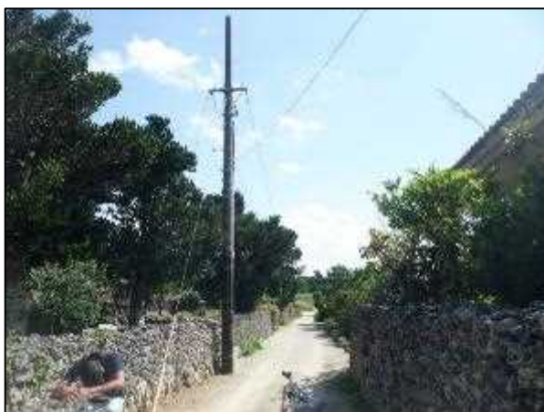
写真㊻ 高圧線埋設部 4
