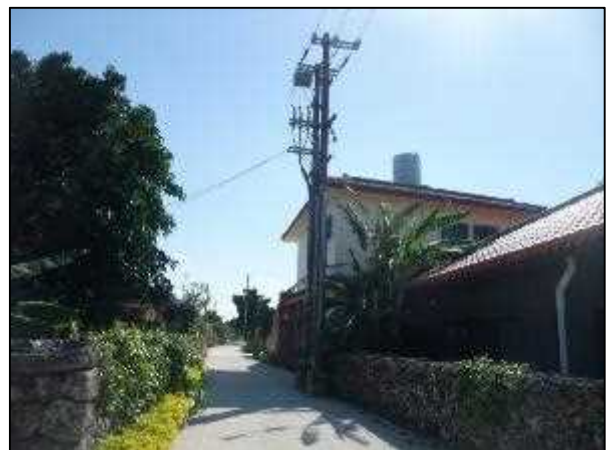
写真㊫ 高圧線埋設部 3
