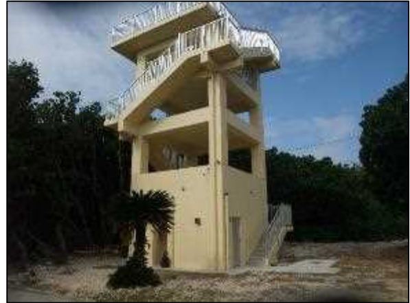
写真② 津波対策の避難塔
