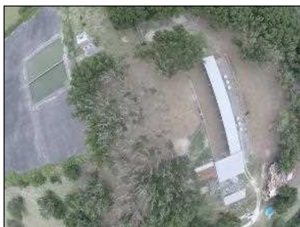
写真⑱ 畜舎及び雨水溜池(畜舎側)
