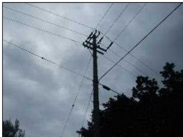
写真⑭ 高圧線分岐
