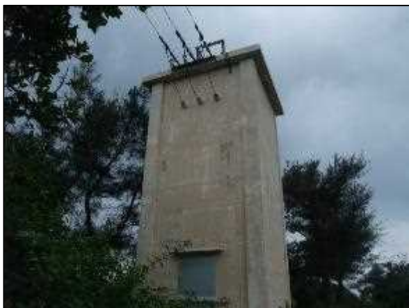
写真⑬ 海底ケーブル立ち上がり
