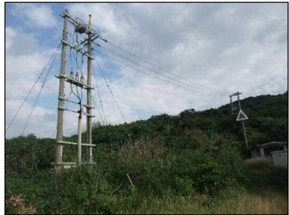
写真② 海底ケーブル立ち上がり
