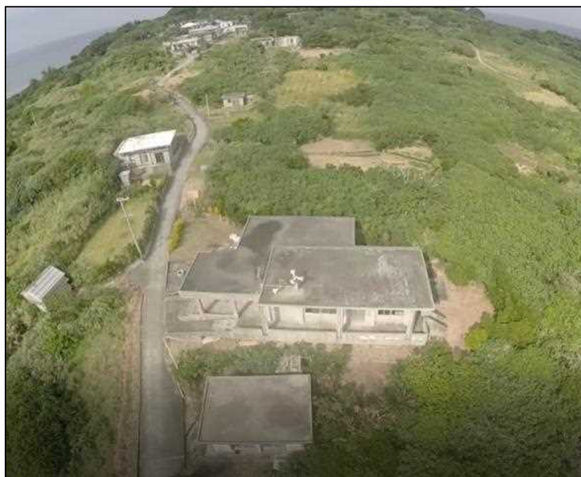
写真 1-1. 候補地(コミュニティセンター屋上)
