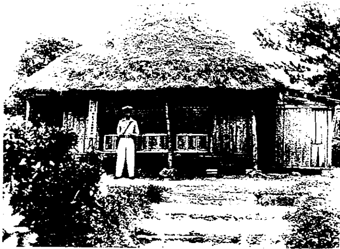
▲ 渡久地署巡査駐在所 (年代不詳)
