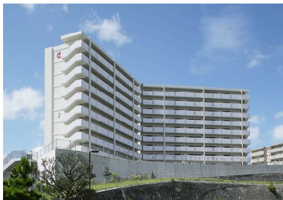
北西側外観（役場側）
