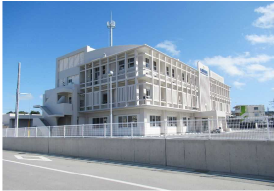
庁舎棟 南西側外観
