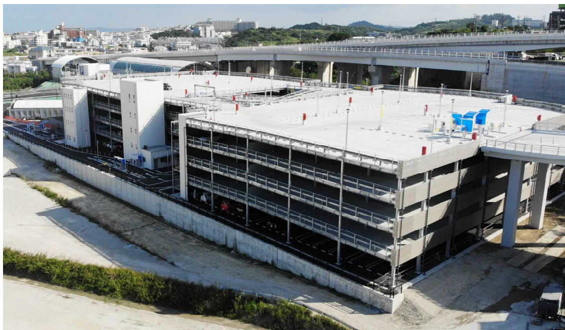
てだこ浦西駅パークアンドライド立体駐車場（浦添市）
