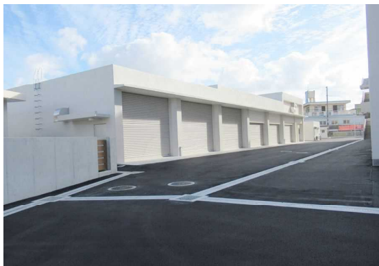
車庫・倉庫棟 外観
