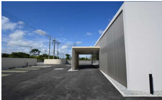
車寄せ・駐車スペース
