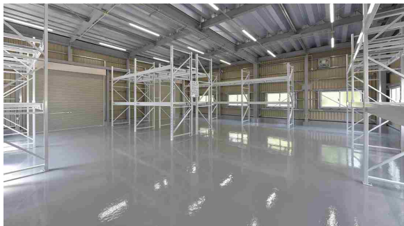
防疫資材備蓄倉庫 内部
