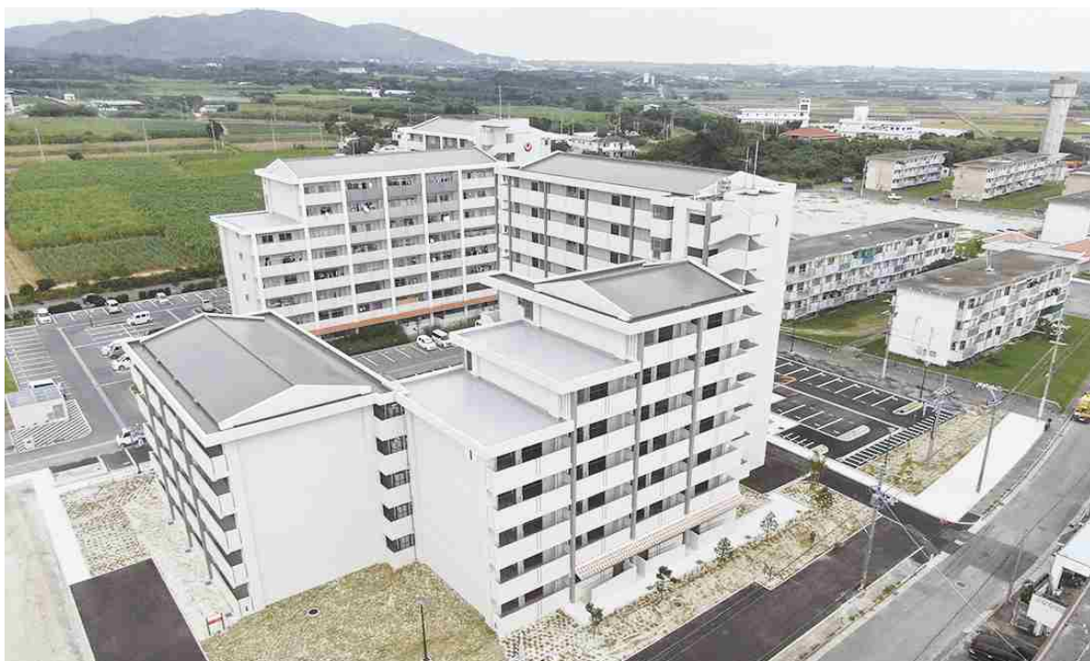
南東側からの俯瞰（奥は1期工事）
