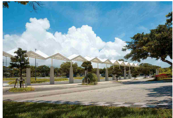
駐車場側からみる
