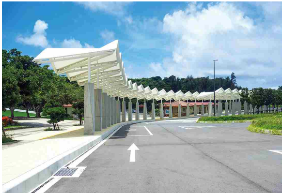
車両アプローチ
