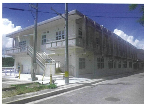
南側より（外観）
