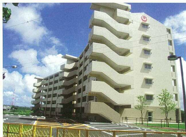
北西より(外観)
