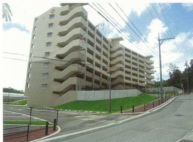
北西より(外観)
