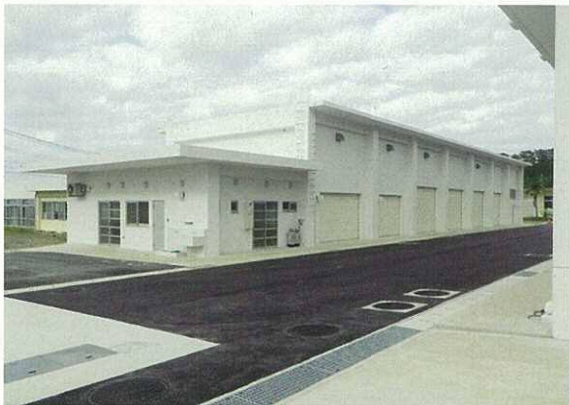
農機具格納庫北側外観
