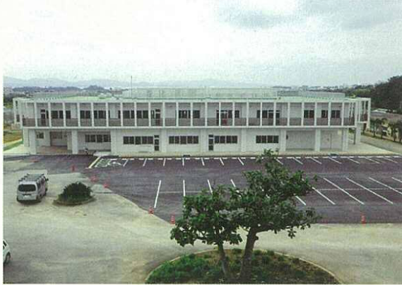
本館北側外観
