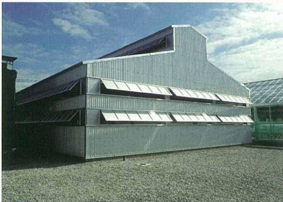
発生舎北側外観
