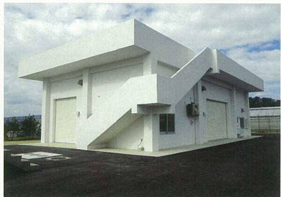
木材加工実験棟東側外観
