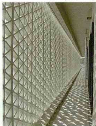
外部ルーバー
