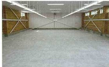
工芸棟引染工房
