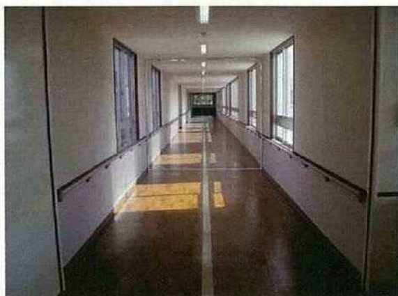
各棟を繋ぐ中廊下
