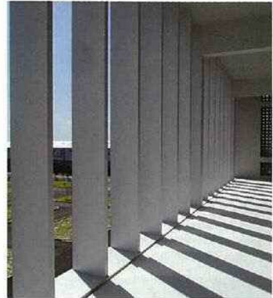
■南面の縦ルーバー
