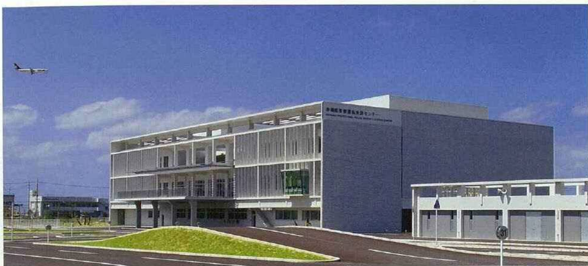
■ 幹線道路側遠景
