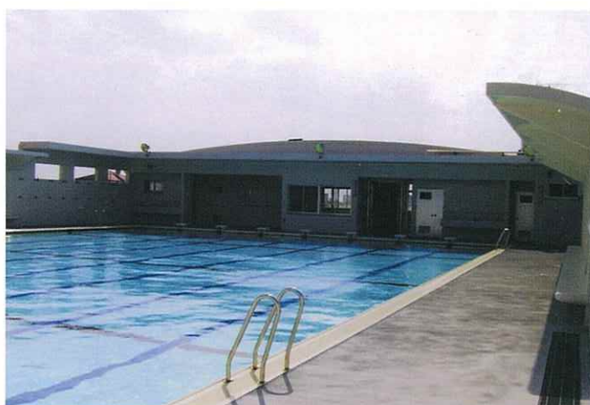
3階プール（南側）
