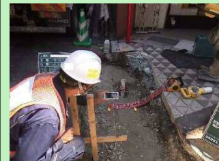
【検査状況（現場側）】
