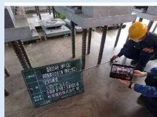
【検査状況（現場側）】
