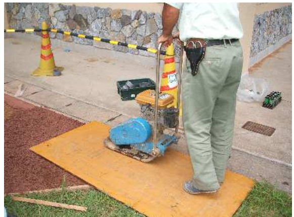
写真-3 締め固め施工状況
