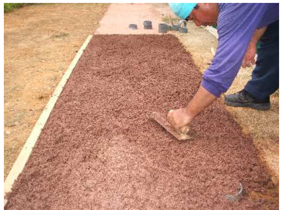
写真-2 敷き均しめ施工状況
