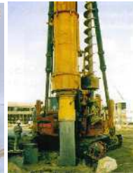
施工例(イメージ図) 早強ポルトランドセメント
