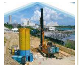
施工例(イメージ図) セメント系固硬化材
