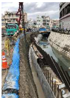
施工例(イメージ図) 基礎周辺の埋め戻し
