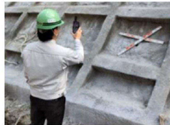
標尺設置状況
