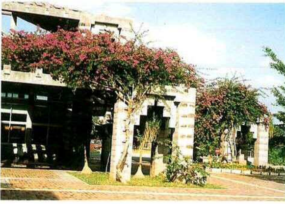
● 構造物の壁面や足下に緑を配することで印象をやわらげている。 (名護市庁舎)
