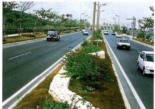
● 中央分離帯に低い石垣と植栽により、シーケンス景観を形成している。 (国道332号)
