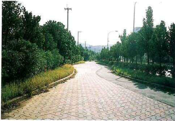
●緑地にゆとりを持たせた広幅員歩道を整備することで、樹木の生長とともに良好な歩道景観が形成される。
