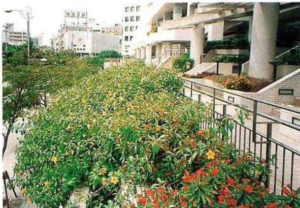
● 幹線道路沿の建物の緑化を促進し、道路景観に取込む。 (那覇市、久茂地)
