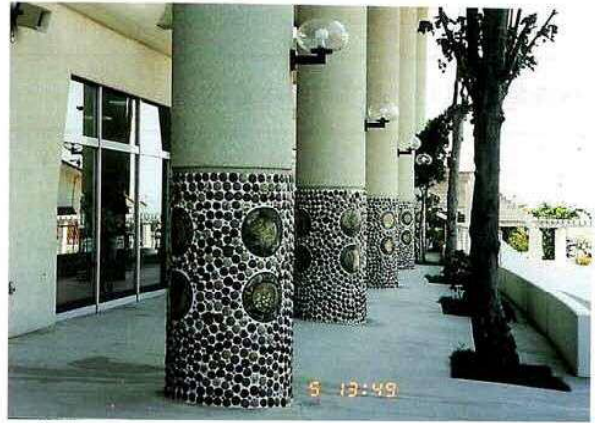
● 視線高さで表面仕上げを変えることで構造物の分節化を図る。 (糸満市)
