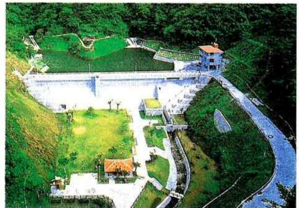
● 弘周辺の造成法面緑化。(座間味ダム)
