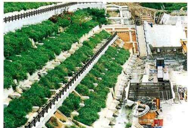
● 弘周辺法面を緑化ブロックで整備している。(那覇市、金城弘)
