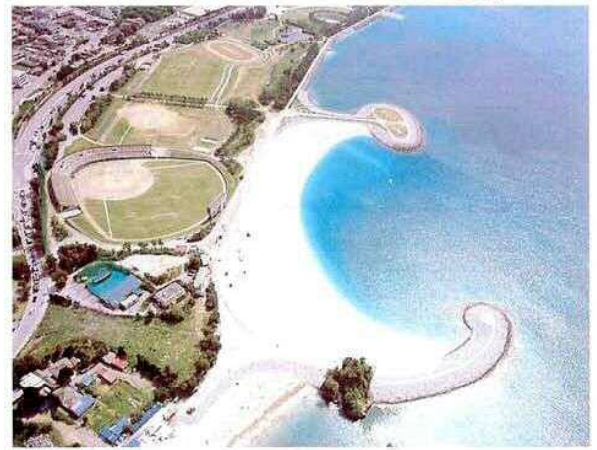
● 親水型防波堤 従来の波浪防御機能に加えて、防波堤上での魚釣りや散策等に適した構造とすることによって、人々が海と親しみ、憩い、遊ぶことができる。 (名護市 21世紀の森公園)
