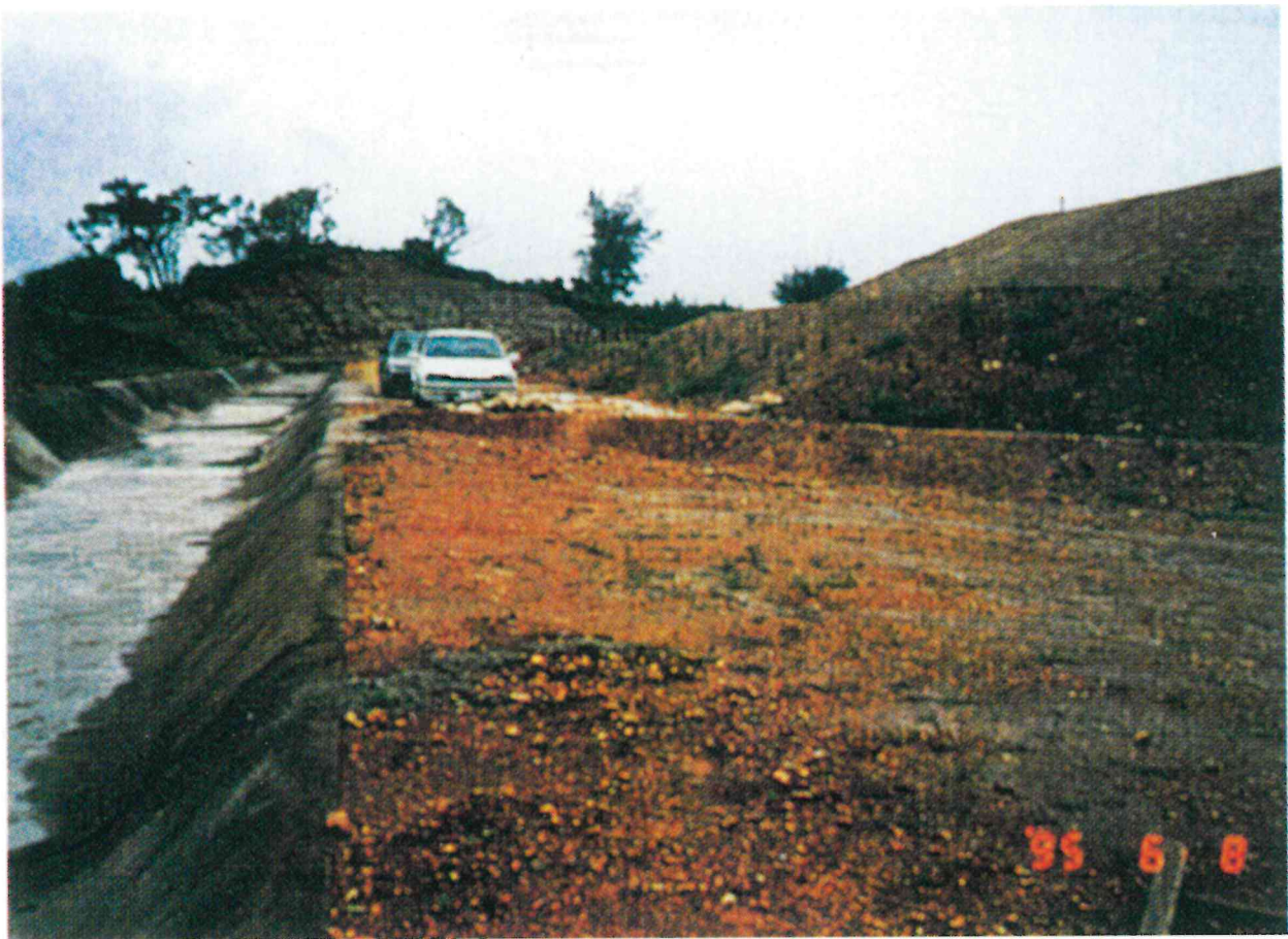
モルタル吹き付けを施した切回水路
