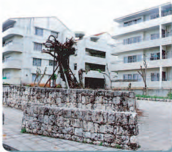
② 沿道とゆるやかにつながる構内舗装と低い石灰岩の石積みが開放的な印象を与えている。 (平良市宮馬場団地、平良市)
