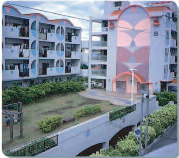
① 建築物の地下に駐車場を設け、又その上を人工地盤として緑化することで印象をやわらかくしている。 (北谷町営栄口団地、北谷町)
