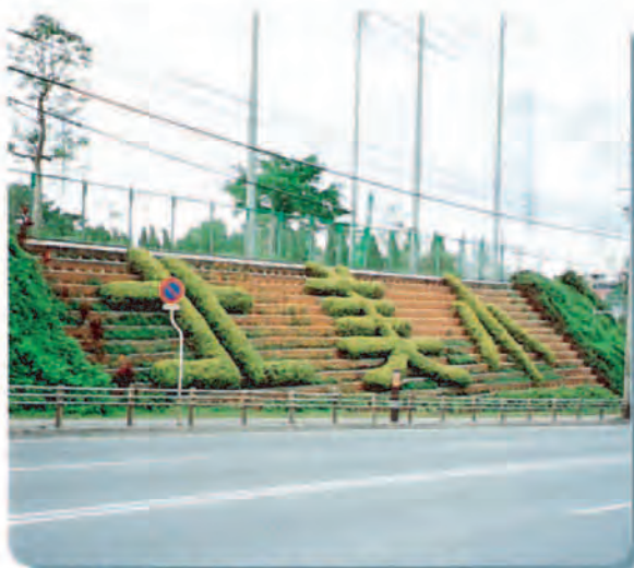
③ 沿道と敷地と段差のある擁壁斜面を緑化により、自然に沿道面にすりつけている。 (北美小学校、沖縄市)
