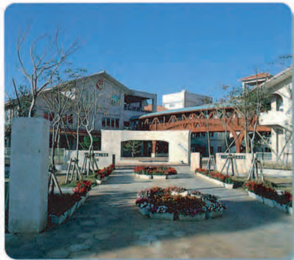
③ 正門の前庭にはヒンプンを模したゲートを設けるなど親しみのある景観となっている。 (浦城小学校、浦添市)
