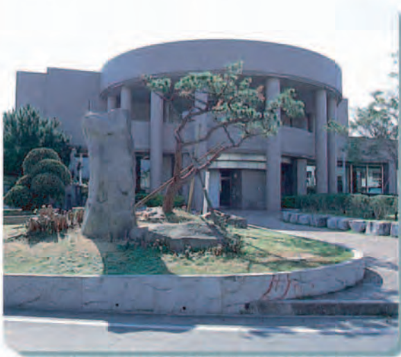
③ 建築物と歩道との間の緑地が開放的な空間となって、市民に提供されている。 (宜野湾市民図書館、宜野湾市)
