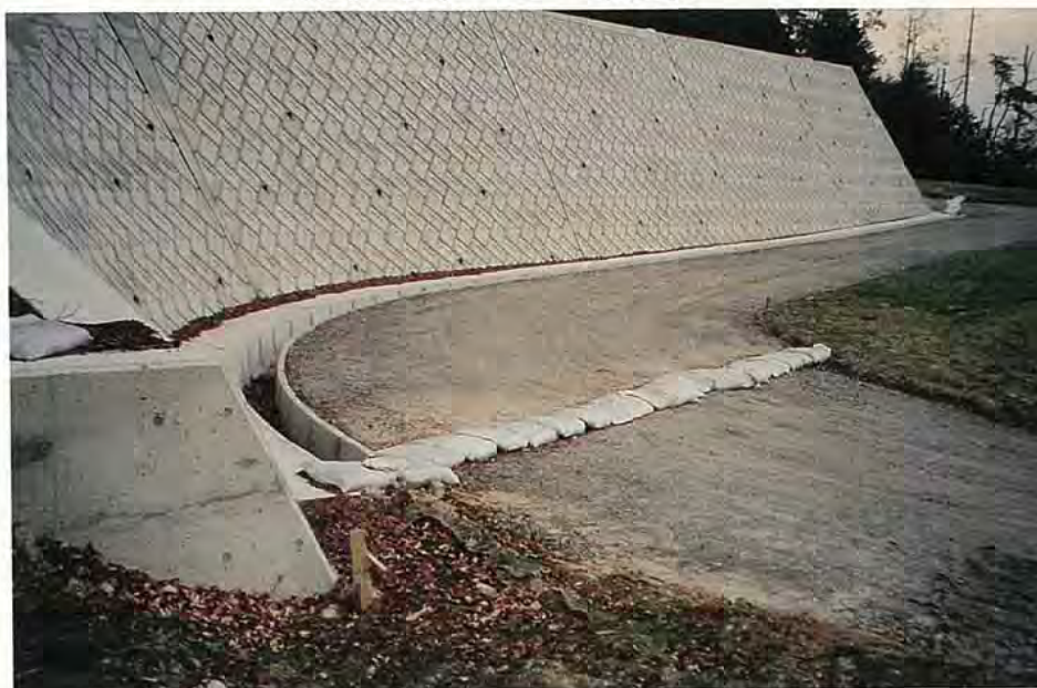
土のうによるハーローの設置例
