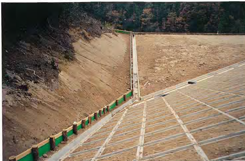
法尻に設置した柵工の例
