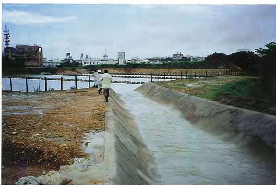
モルタル吹付の例
