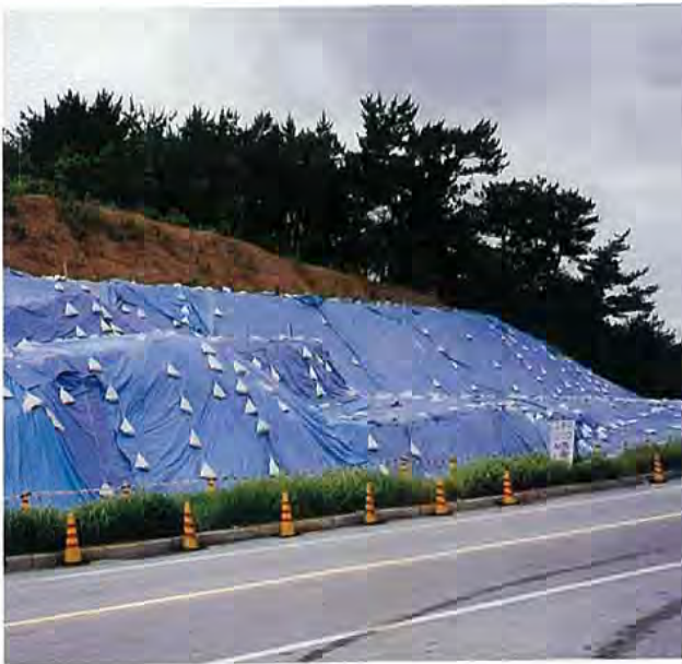
法面シート被覆工の例
