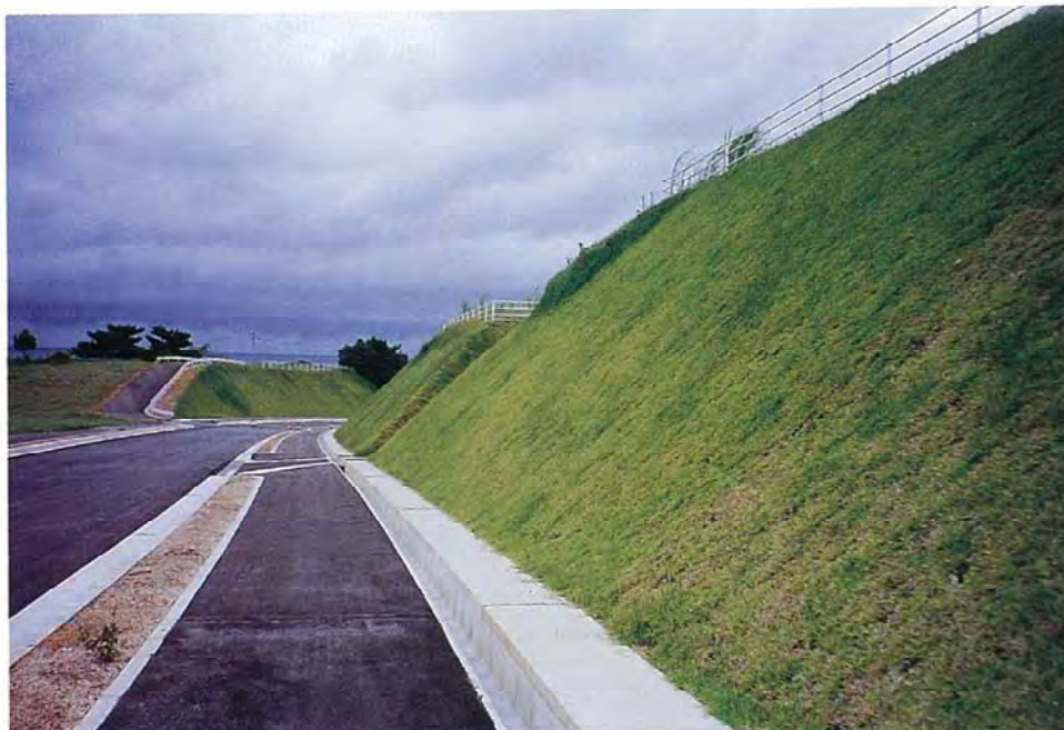
バスケット工法によるのり面芝工の例
