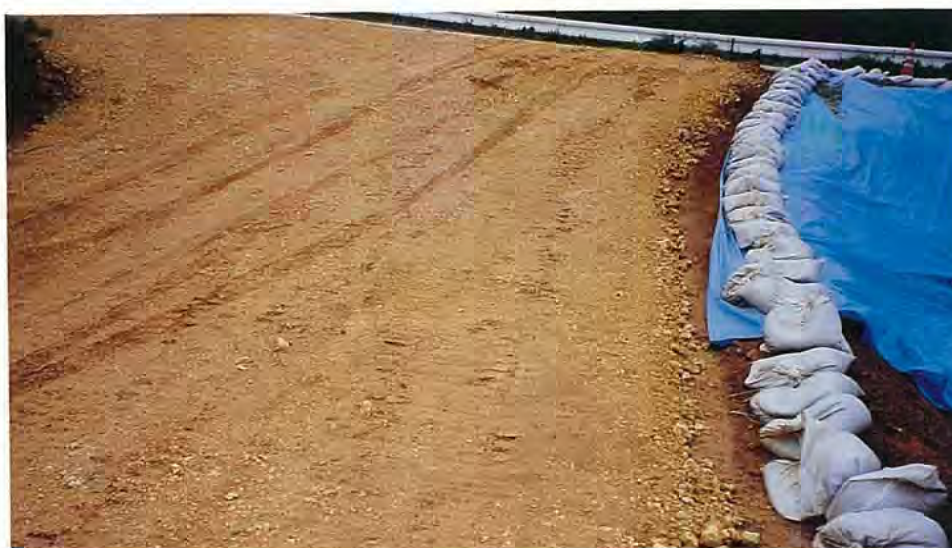
工事用道路の砂利敷設の例
