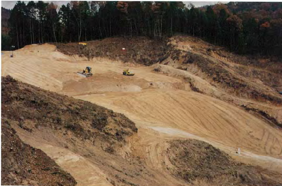
転圧締固の施工
