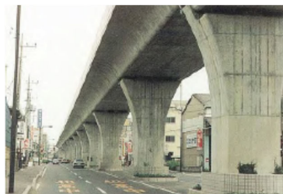
上部工との関連性が高い橋脚形状とすることで、構造物としてのまとまりを生み出している。
