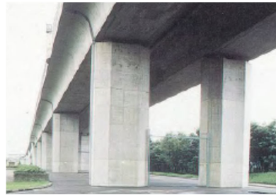
リブや面取りにより橋脚に陰影をつけることで、近くから見られても質感が高いデザインとしている。
