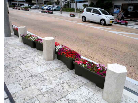
琉球石灰岩によるブロック舗装 龍潭通り（那覇市） 出典：* 2
